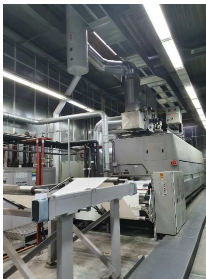
Bild: Neuer Trockner positioniert, Kühlwerk in neuer Position
